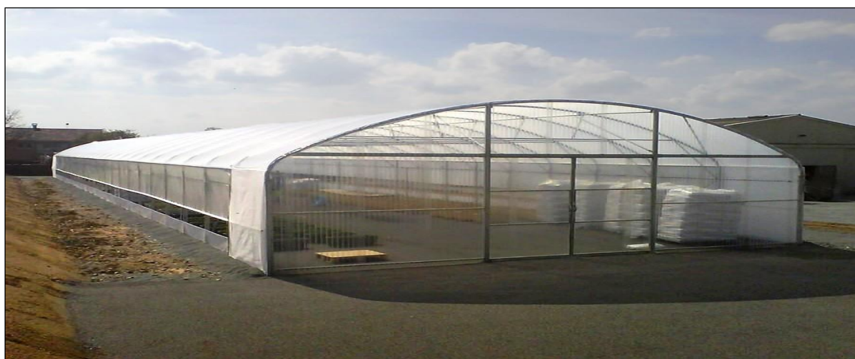
شکل ۱۳ - تیپ عمومی گلخانه تونلی ایستاده تک دهانه (Straight)
