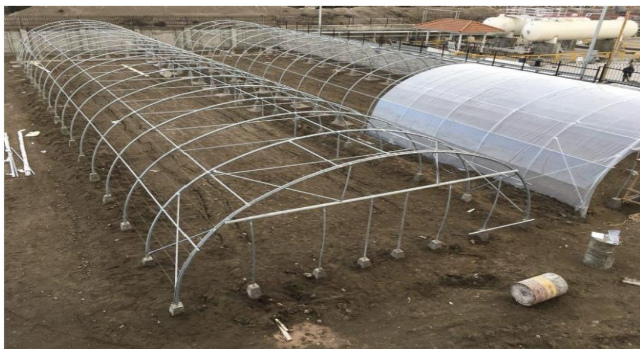
شکل ۳۷ - گلخانه کوچک مقیاس در حال احداث
